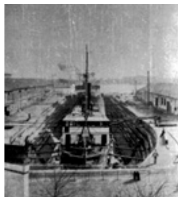
Chantier naval de Jiangnan
