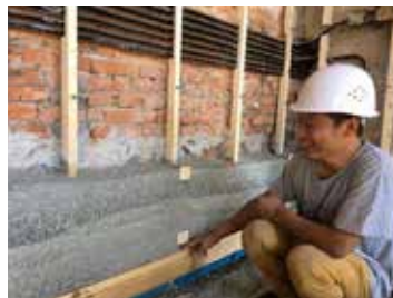
Réalisation de l'isolation en chaux-chanvre dans la vieille maison
