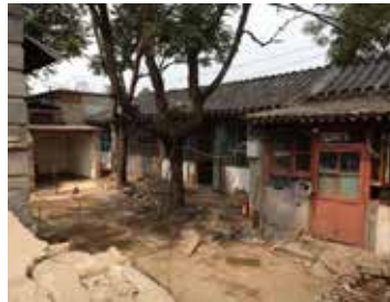
Maison originale (après démolition des extensions sauvages)
