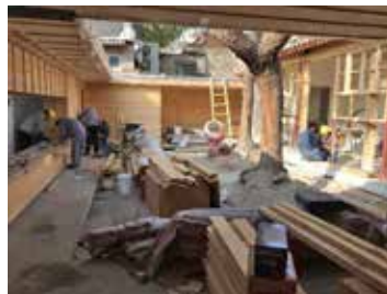
Vue générale du chantier (galerie contemporaine en CLT à gauche + maison historique en rénovation à droite)
