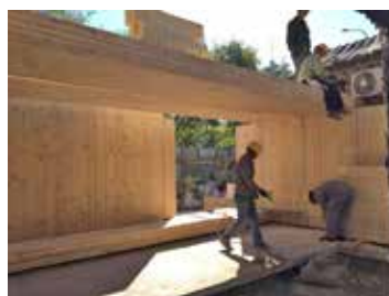
Montage de la structure CLT dans la cour
