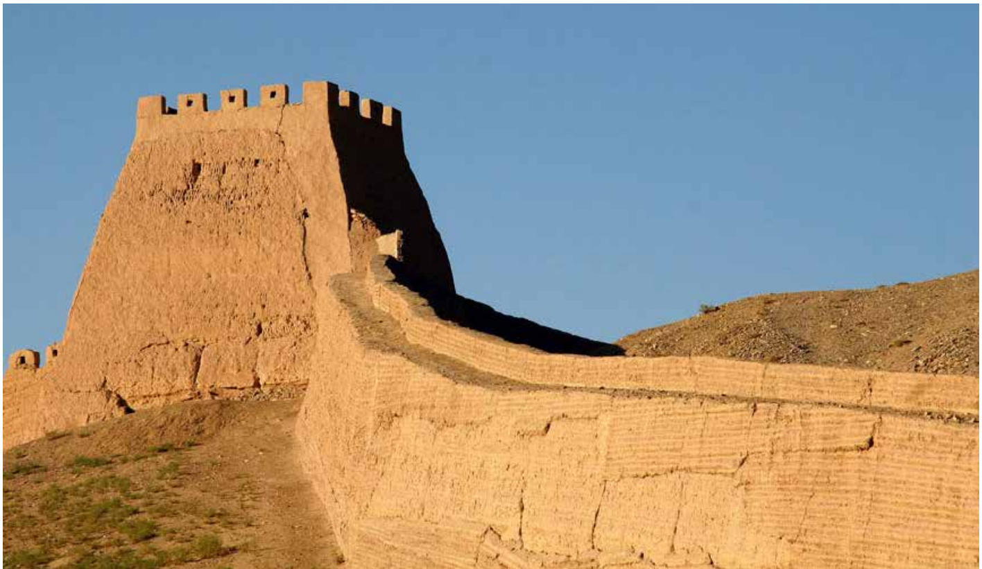
Figure 3 : Mur en Roseaux et Terre –D Hubert
